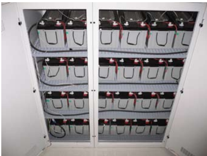
Baterii 200 Ah cu BACS în dulap baterii pentru Quasar
