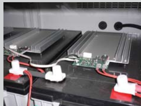
Module integrate în șirul de baterii
