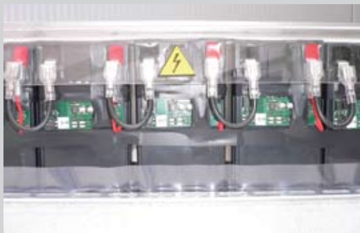
Module integrate în șirul de baterii
